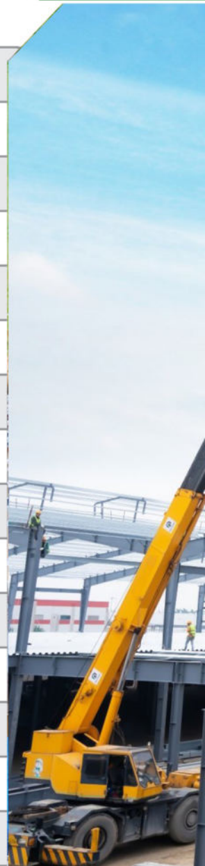
Máy ép cọc
