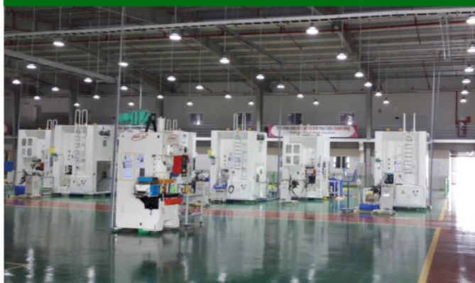
Thi công điện nước
