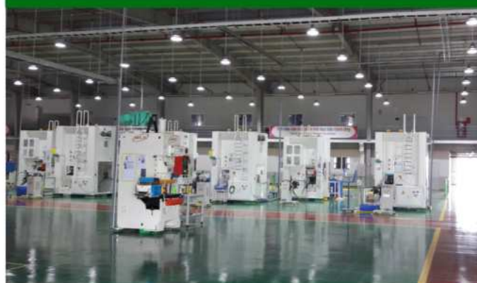
Thi công điện nước
