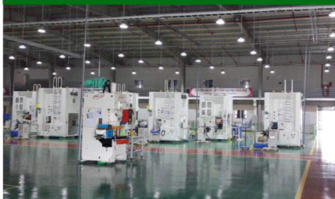
Thi công điện nước
