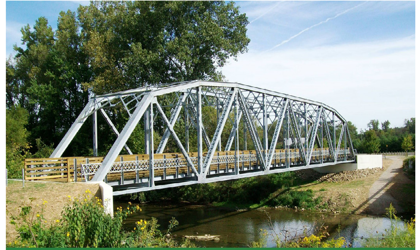
Kết cấu cầu vượt
