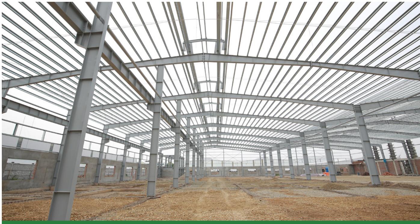
Kết cấu nhà xưởng
