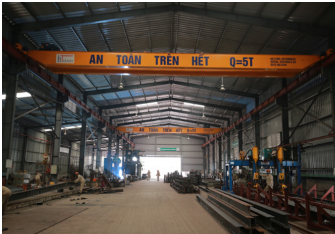
Cầu trục 5 tầng
