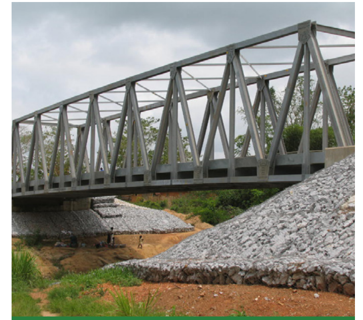
Kết cấu cầu vượt
