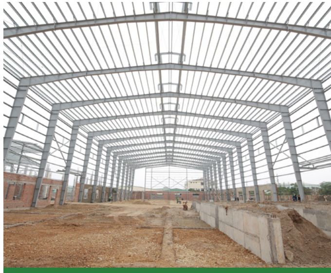
Kết cấu nhà xưởng
