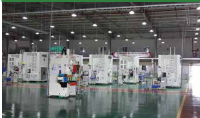
Thi công điện nước
