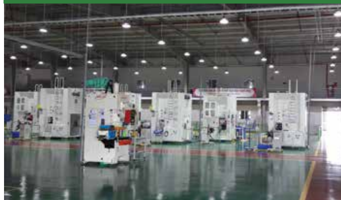
전기 및 수고 설치
